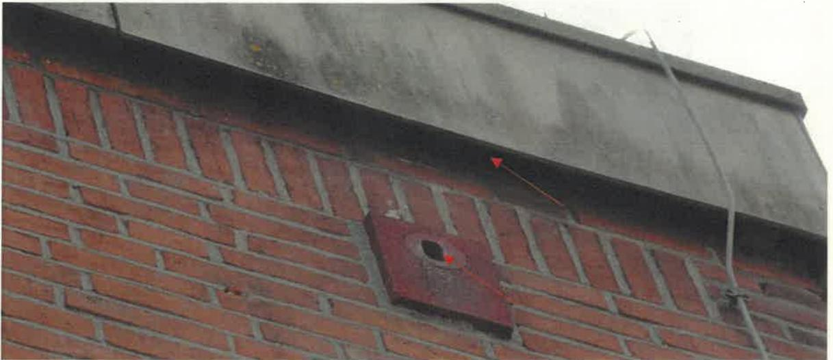
Abbildung 20: Öffnungen im Mauerwerk sowie Spalten hinter Blechverkleidung am Dach
