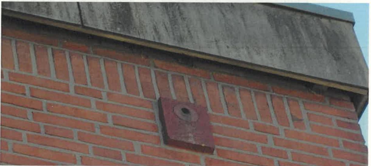
Abbildung 28: Einflugmöglichkeiten durch Spalten hinter der Schichtstoff-Verkleidung und durch Öffnung im Mauerwerk
