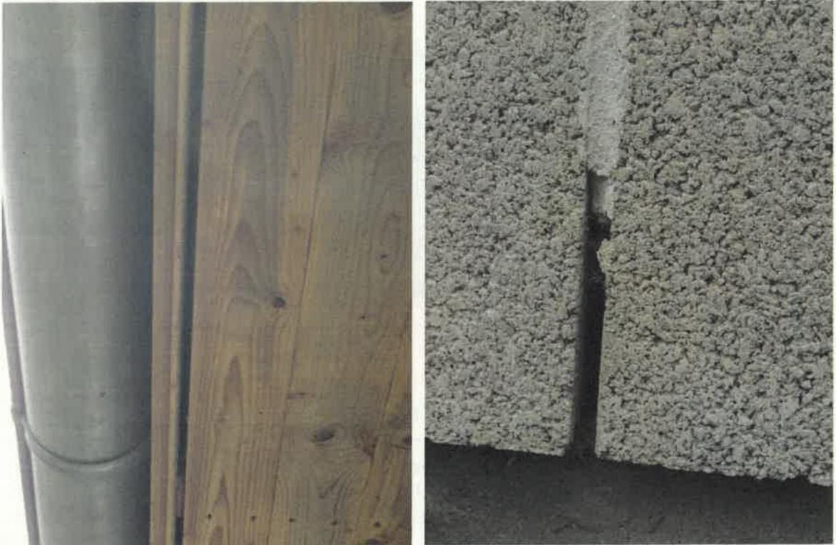
Abbildung 16: Einflugmöglichkeit in Gebäude 2 unterhalb der Attika und in einem Mauerbelüftungsspalt
