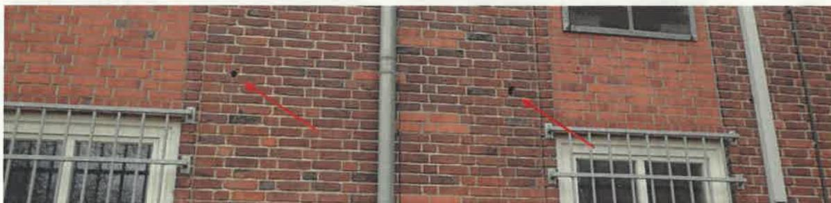
Abbildung 10: Einflugmöglichkeiten in das Mauerwerk des Gebäudes Nr. 1
