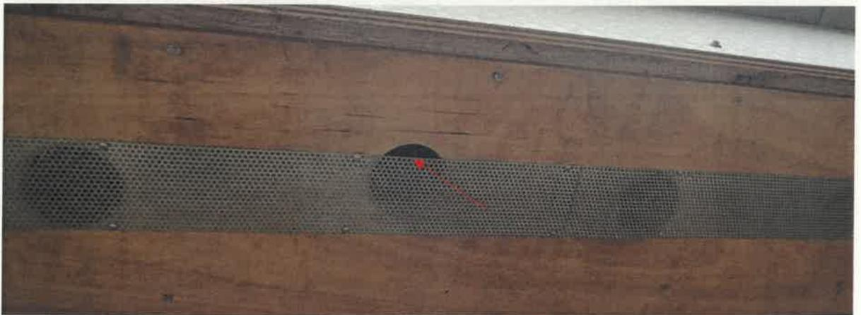
Abbildung 15: Einflugmöglichkeit unterhalb der Attika durch fehlerhafte Abdichtung
