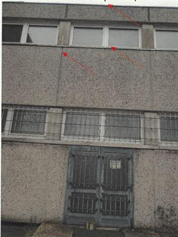
Abbildung 13: Verbindungsgang mit Dehnungsfugen und Attika
