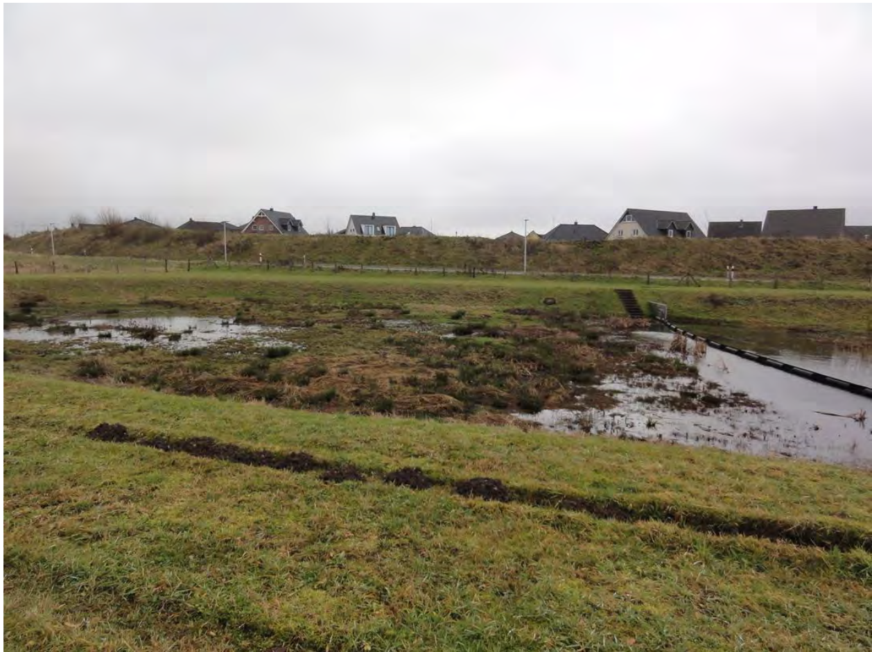
Abbildung 8: Regenrückhaltebecken südwestlich des Plangebietes, Blick nach Süden
