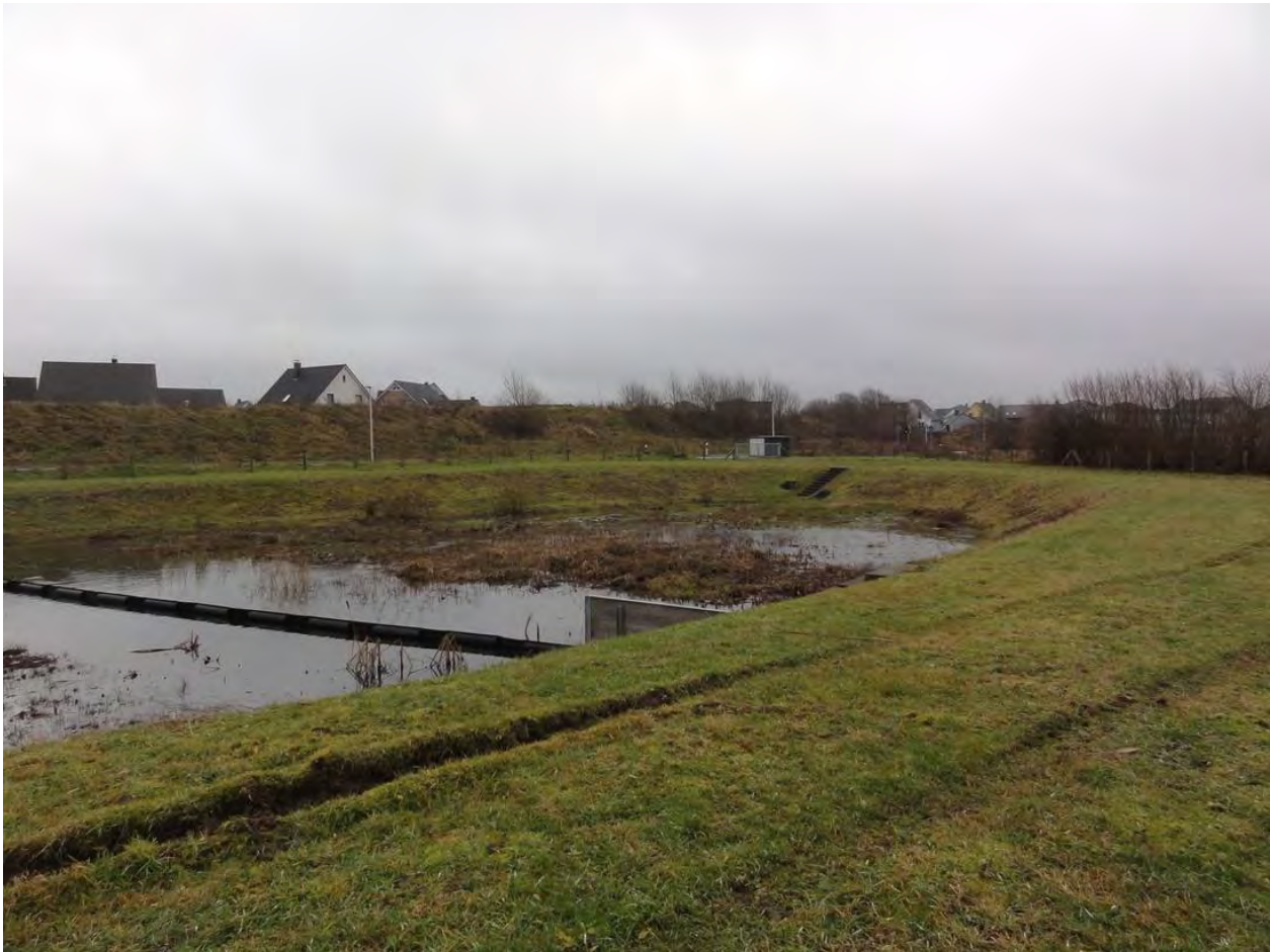
Abbildung 9: Regenrückhaltebecken südwestlich des Plangebietes, Blick nach Südwesten
